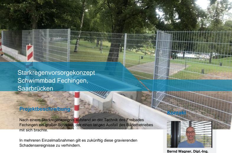
Eine erste Maßnahme behandelte den Bau einer abgestuften Winkelwand mit definiertem Überlauf in ein neues Schachtbauwerk. Die Weiterführung erfolgt durch einen Kanal mit Anschluss an die vorhandene Bachverrohrung.
